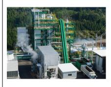
2013年11月に、未利用材のみを燃料にした木質バイオマス発電所として完成。場所は、日田郡森林組合横で、敷地面積は約2万7千㎡。 親会社「日本フォレスト」の処理工場で作られた乾燥木質チップを燃料にする。
